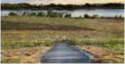
笠田地区歩道橋設置予定地より南へ望む
