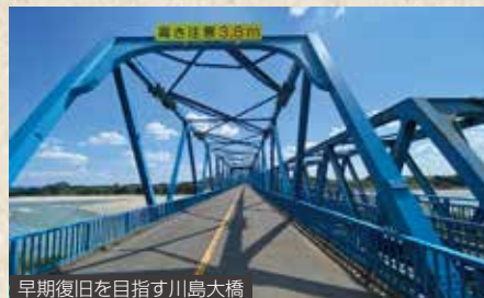
早期復旧を目指す川島大橋
